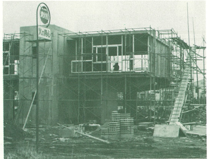
■ユニークな組合会館外観
