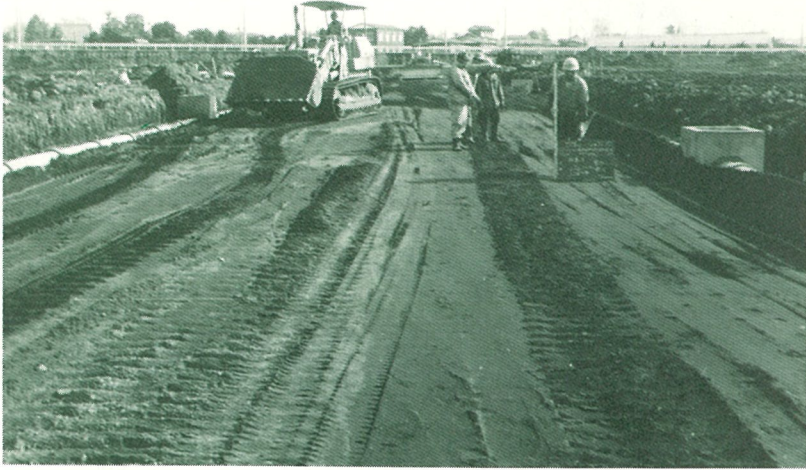
■中央道路造成工事
